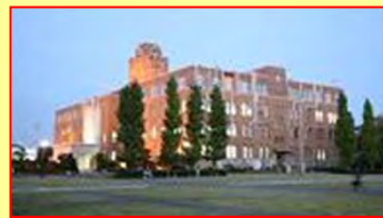
茨城県三の丸庁舎 (事案発生現場)
